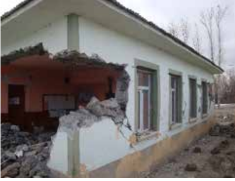
Resim 2: Bir okul binasının taş duvarlarında düzlem içi ve düzlem dışı hasar oluşumu (Tabanlı-Van Depremi, 2011).
