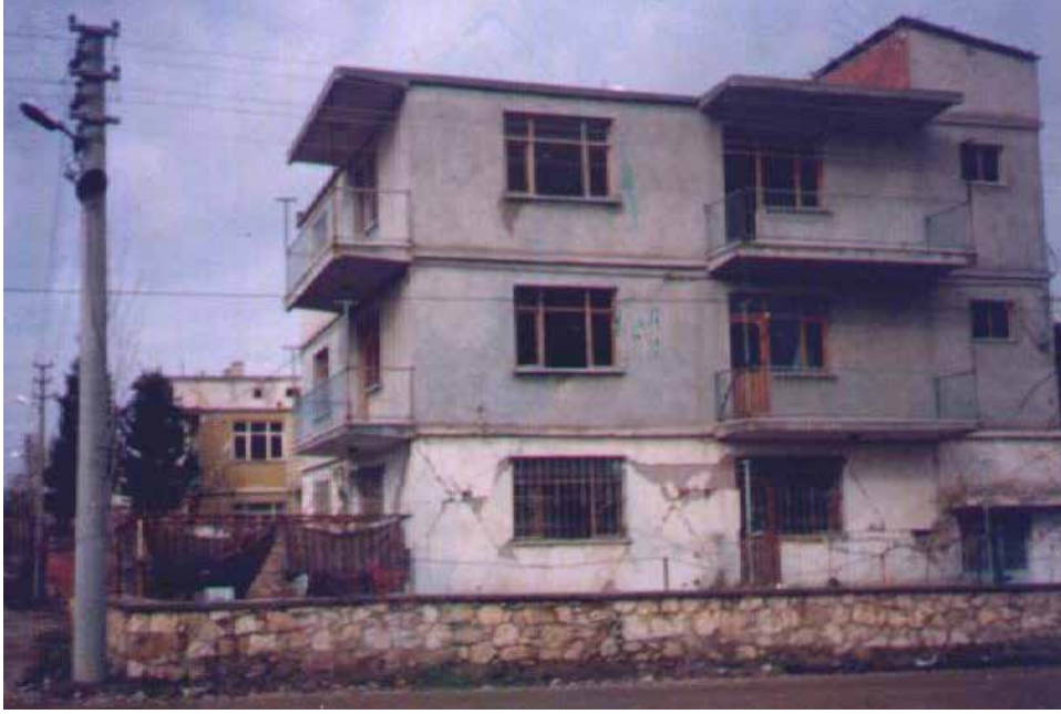
Resim 1: Yığma bir binanın tuğla duvarlarında oluşan köşegen çatlaklar (Dinar-Afyon Depremi, 1995)
