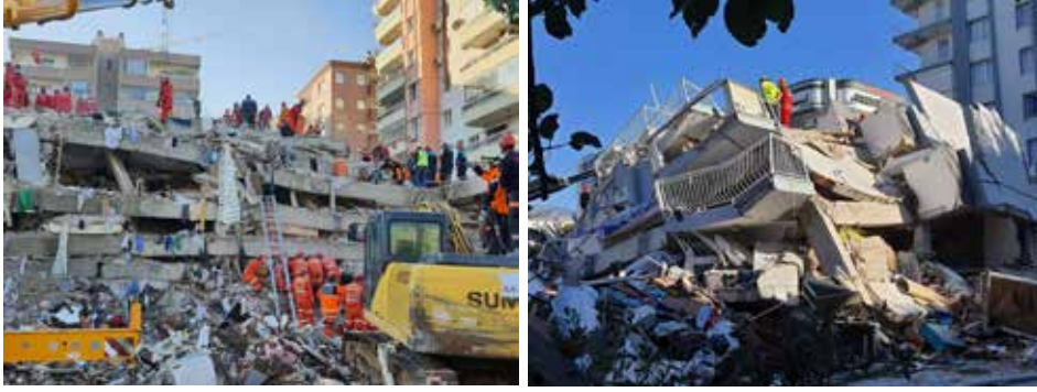
Şekil 1. Depremde toptan göçen betonarme binalar
