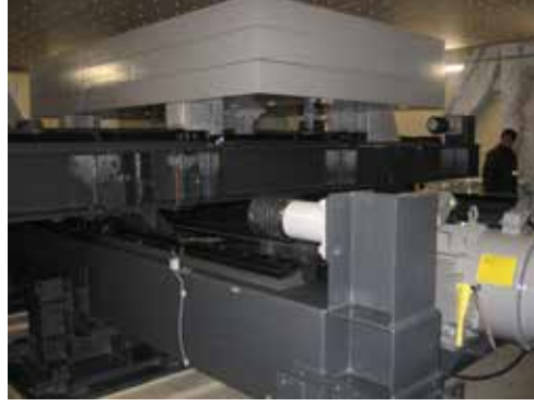
(b) Çok katlı bir binada kullanılan ayarlı kütle sönmüleyici sistemi
