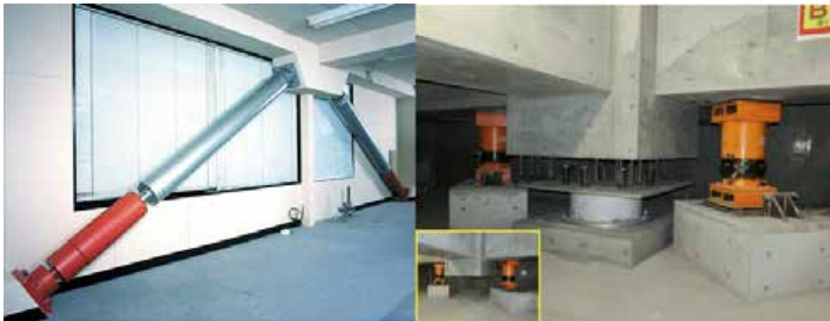
Şekil 3. Sönümleyicili ve sismik izolatörlü tasarım sistemi örneği[8]
