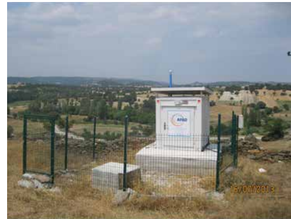
Deprem Gözlem İstasyonlarının Dış Görünüşü
