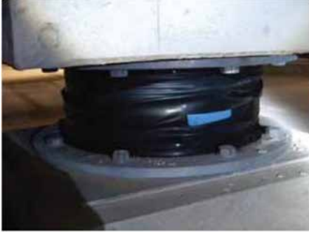
Şekil 4. 2016 Kumamoto Depreminde sismik izolatörlerde gözlenen hasarlar
