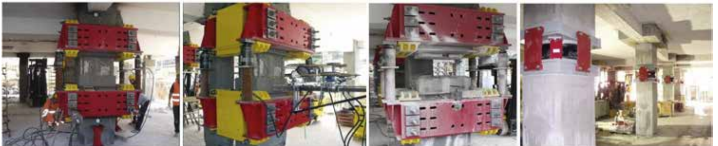
Şekil 7. Sismik izolasyon ile güçlendirmede izolatör montaj aşamaları (Erdik M. vd. 2018)
