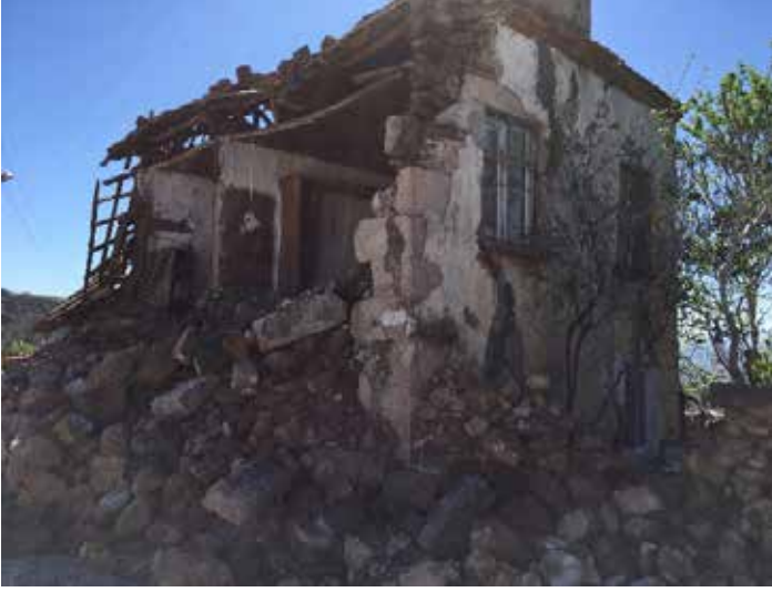
Resim 3: Konut binalarının taş yığma duvarlarında düzlem içi ve düzlem dışı hasar oluşumu, çatısı toprak dam (sağdaki) olan bina (Ayvacık-Çanakkale Depremi, 2017).
