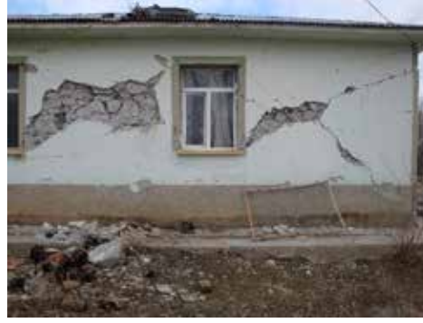
Resim 2: Bir okul binasının taş duvarlarında düzlem içi ve düzlem dışı hasar oluşumu (Tabanlı-Van Depremi, 2011).
