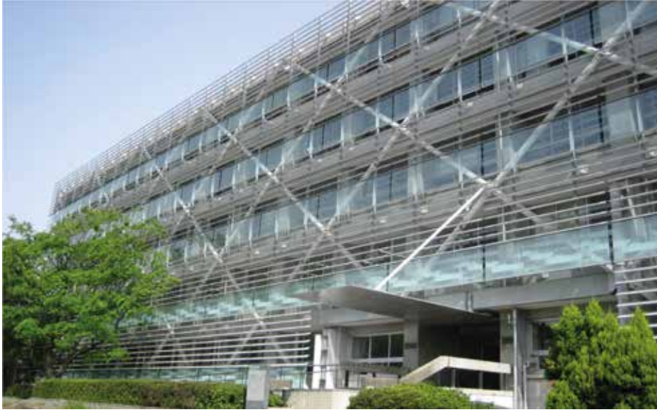
Şekil 6. Enerji sönümleyiciler ve entegre cephe sistemi ile dışarıdan güçlendirme örneği.
