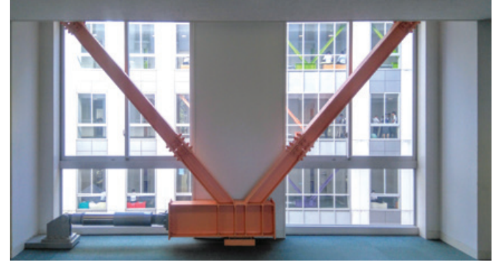
Şekil 1. (a) Viskoz sönümleyici bileşenleri (Taylor, 2022)
