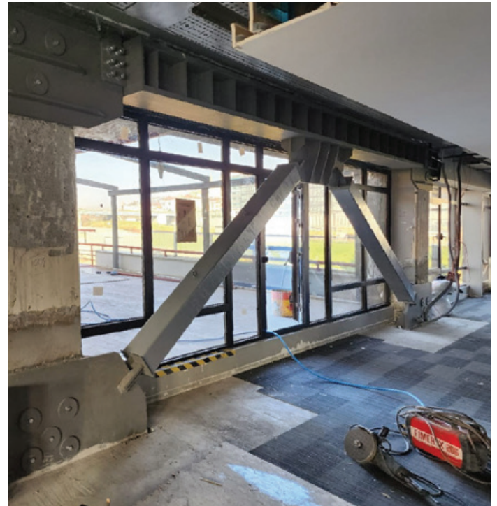
Şekil 7. Burkulması önlenmiş çaprazlarla güçlendirme uygulaması
