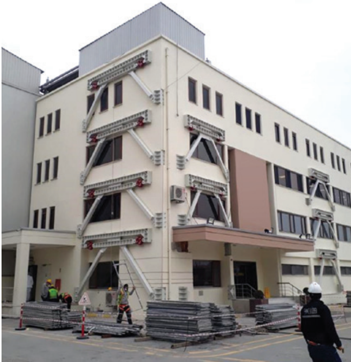
Şekil 6. Sürtünme esaslı sönümleyicilerle dışarıdan güçlendirme uygulaması
