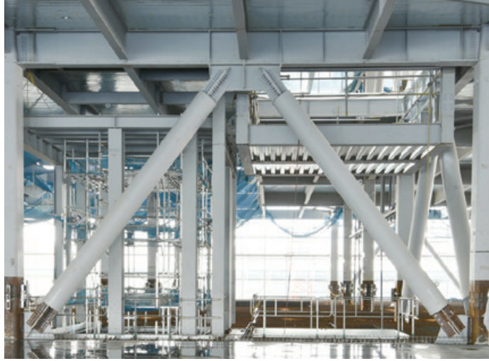
Şekil 3. (a) Burkulması önlenmiş çapraz bileşenleri ve çevrimsel davranışı (b) Çelik yapıda şevron konfigürasyonlu burkulması önlenmiş çapraz uygulaması
