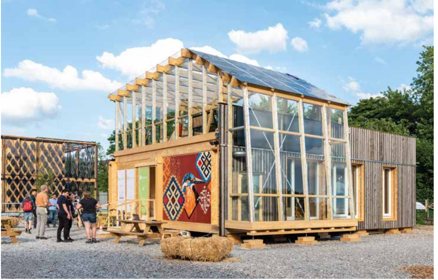
Şekil 4 Wuppertal Solar Decathlon Avrupa kampüsünde inşa edilen demo konut birimi (Fotoğraf: Hacer Bozkurt)
