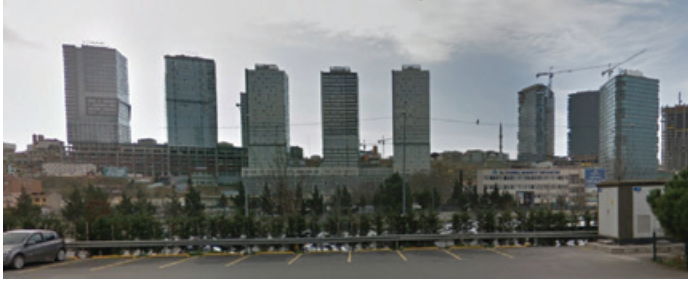
Şekil 4. 6 Şubat 2023 tarihindeki Kahramanmaraş (Pazarcık, Türkoğlu), Hatay (Kırıkhan), Kahramanmaraş (Elbistan, Nurhak-Çardak) depremlerinde kamu yapılarının etkilenmesi (Hatay Eğitim ve Araştırma Hastanesi Ek Hizmet Binası), Kaynak: İTÜ Deprem Nihai raporu, 2023
